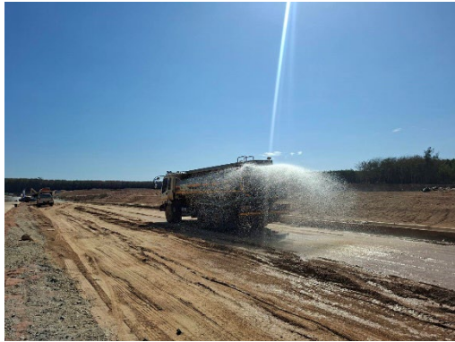
ภาพที่ 2-2 การฉีดพรมน้ำบริเวณพื้นที่ก่อสร้างที่เปิดหน้าดิน
