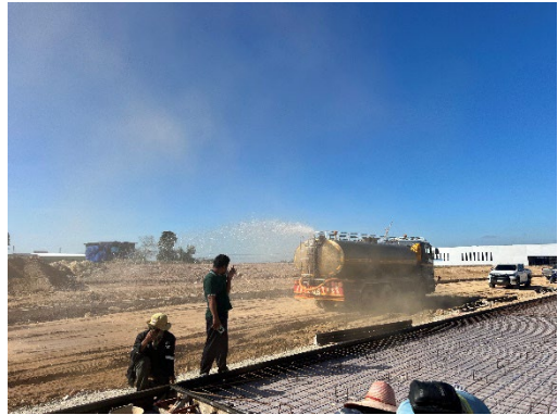
ภาพที่ 2-2 การฉีดพรมน้ำบริเวณพื้นที่ก่อสร้างที่เปิดหน้าดิน
